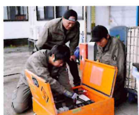
分電盤の組み立て作業。「先輩が丁寧に教えてくれるので助かります」と井川さん
